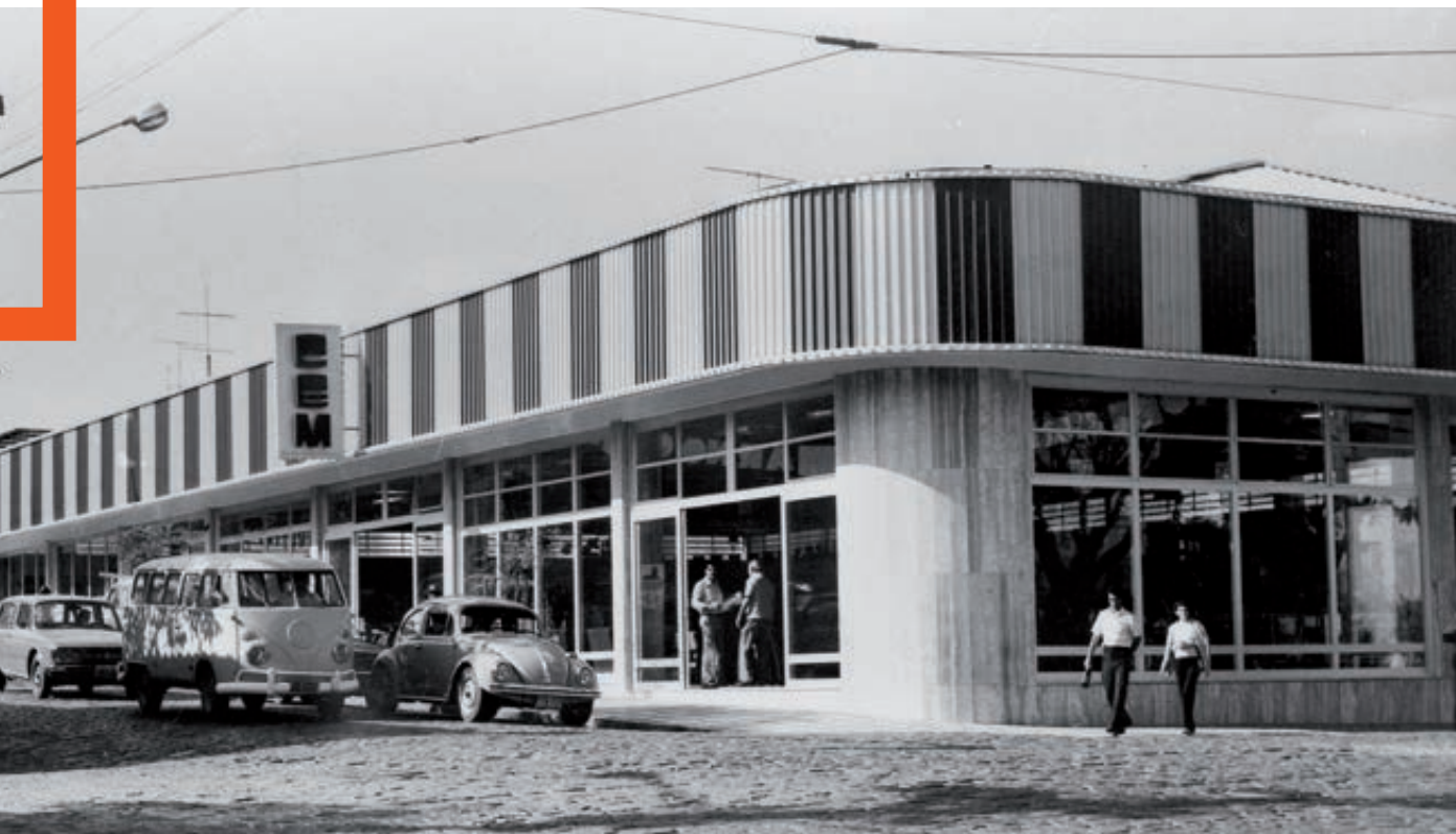
A esquina das Lojas CEM, na cidade-sede (Salto-SP), após a mudança do nome, em 1976 The corner of Lojas CEM, in the main city (Salto-SP), after the name change in 1976
